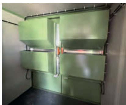
Odprtine za dovod zraka z električnimi loputami serijsko
