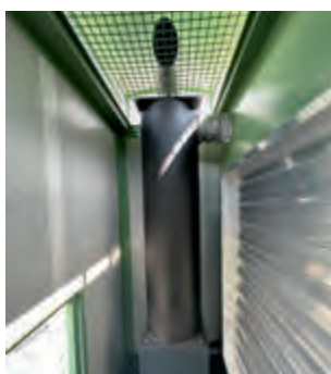
Notranji industrijski dušilec zvoka in električna loputa za izpušni zrak serijsko
