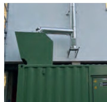
Kanal z odvodom zraka ob strani za zaščito pred vremenskimi vplivi (lahko se odstrani)
